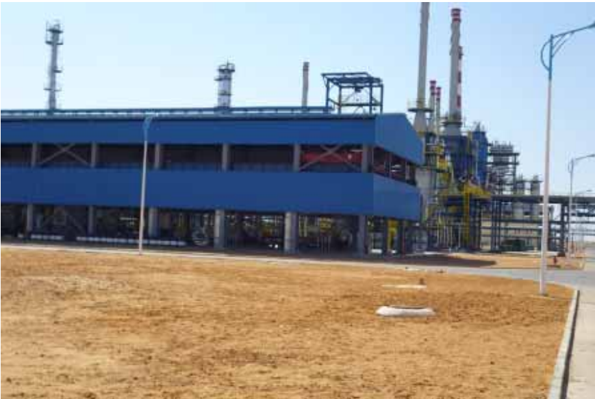
L'USINE DE RAFFINAGE DE LA SORAZ
