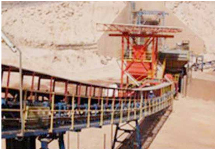
UNE VUE DES INSTALLATIONS DE LA SML
